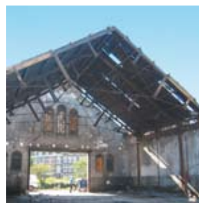
Demontage GVB Hallen
